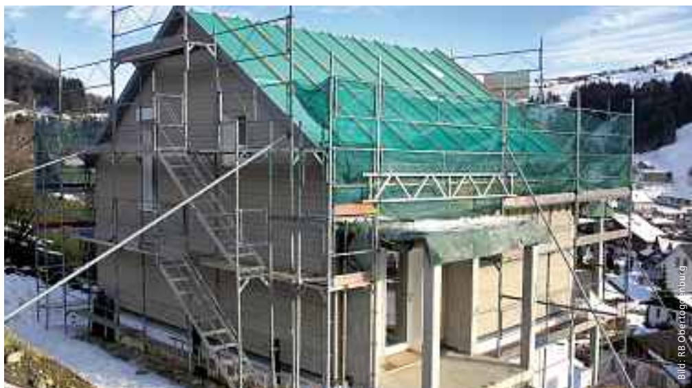
Auf dem Bild noch im Bau: Ab diesem Frühling kann das Passivhaus in Unterwasser probebewohnt werden.
